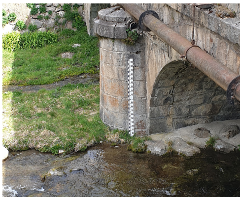
Echelle limnimétrique (échelle de crue) à Mérens-les-Vals (09) | 2020
