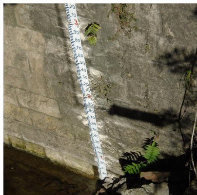
Echelle limnimétrique à Pamiers (09) | 2020
