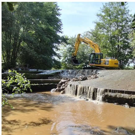
Restauration de la continuité écologique sur l'Arget pendant les travaux (2019)
